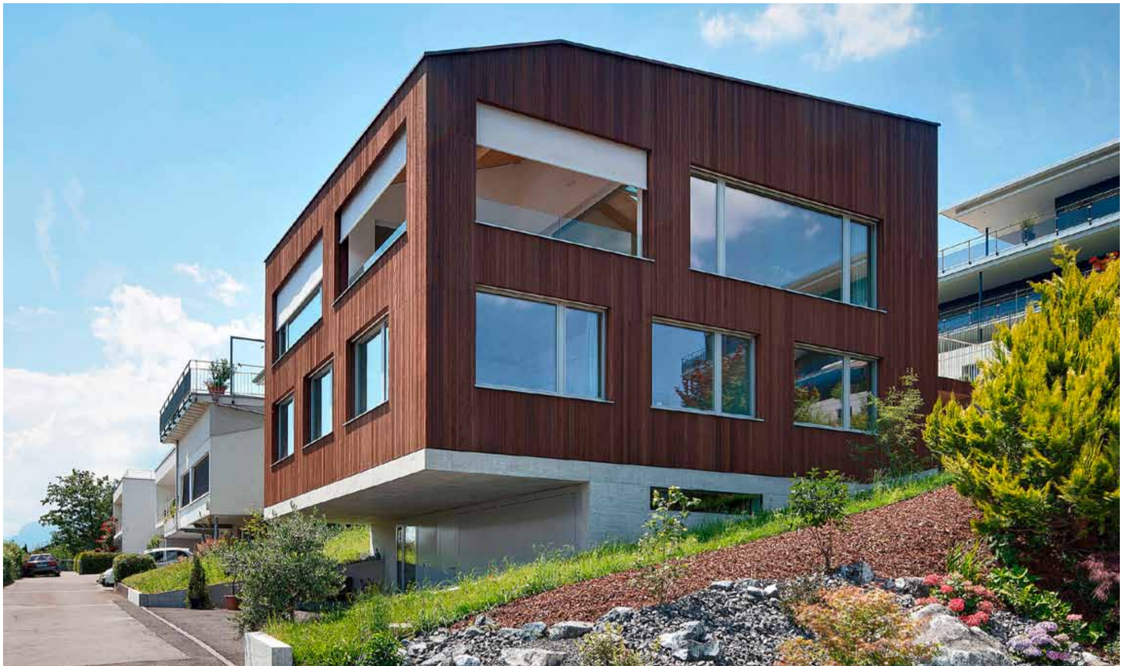
Starker architektonischer Ausdruck: Einfamilienhaus in Merlischachen mit druckimprägnierter, geölter Fassade aus Weisstanne in einem ansprechenden Braunton (Architektur: Schärli Architekten AG, Luzern; Holzbau: Kost Holzbau AG, Küssnacht am Rigi).
