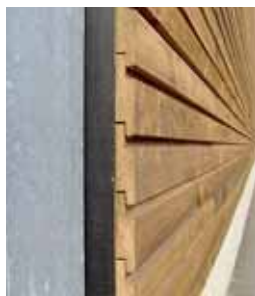
Figure 131: La section d'un lambris- sage de façade montre la profonde pénétration de l'imprégnation.
