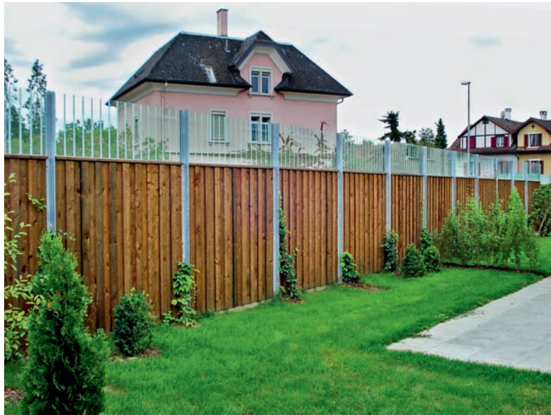
Gut geschütztes Holz für Lärmschutzwände hat zahlreiche Vorteile. Foto: Pletscher & Co. AG
